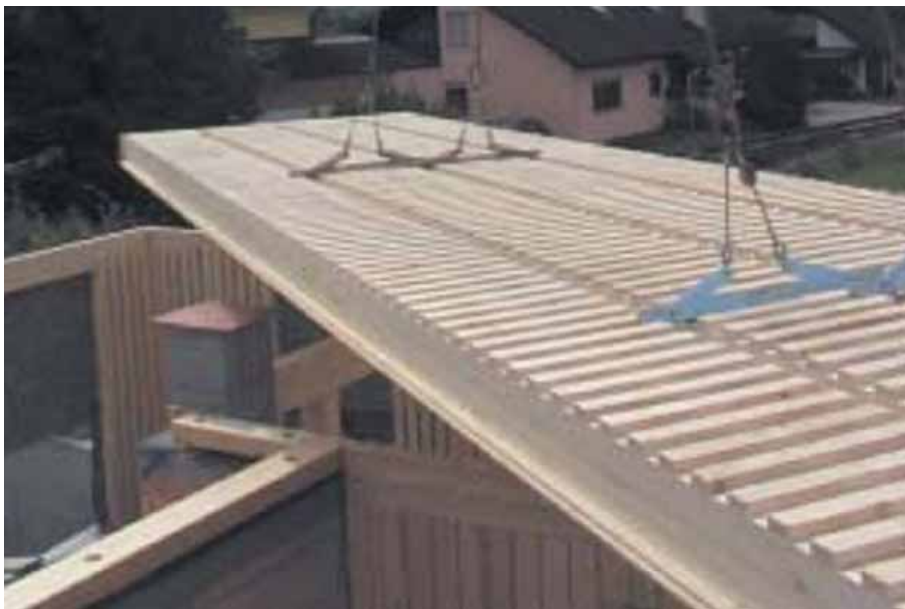
Sistemi a cassone nervato autoportante
