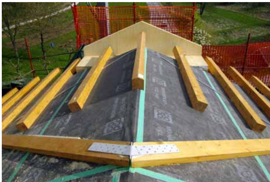
Sistema strutturale sbalzo di copertura
