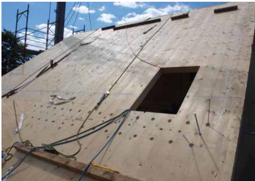
Banchina ed unioni copertura X-lam 140 mm
