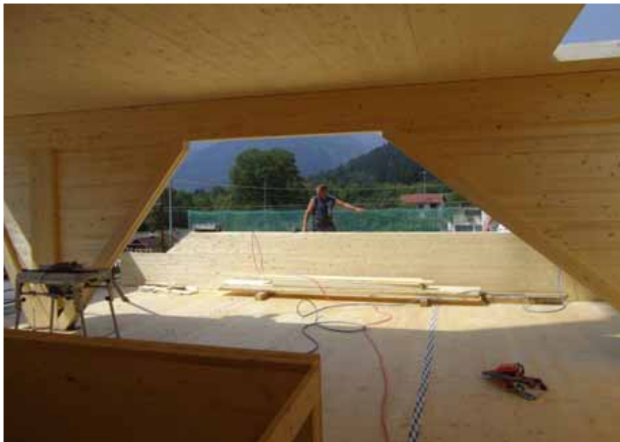
Telaio reggi secondo solaio X-lam 140 mm
