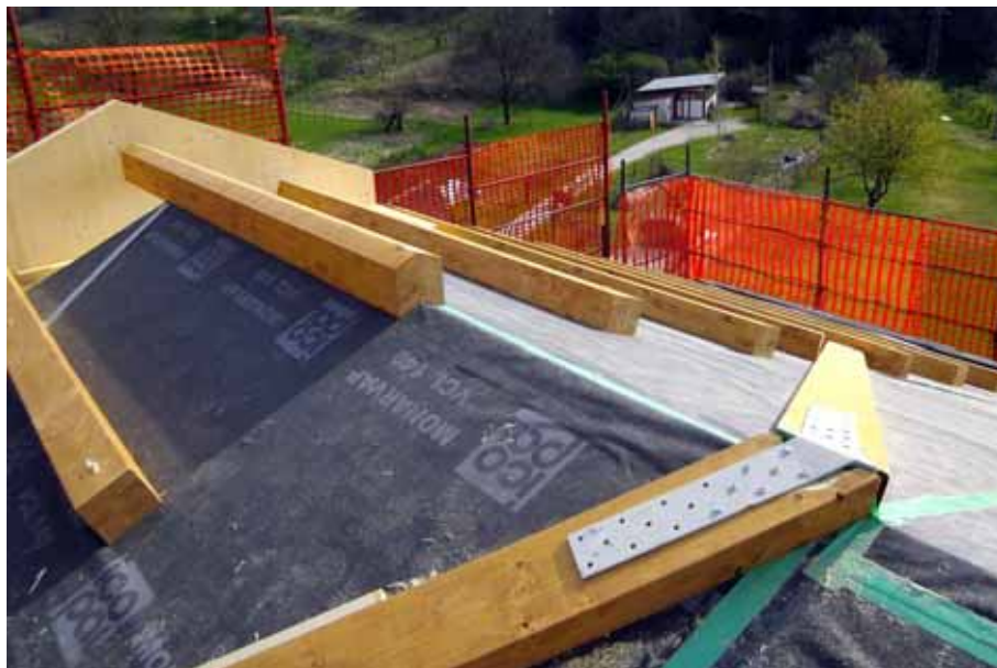
Sistema strutturale sbalzo di copertura
