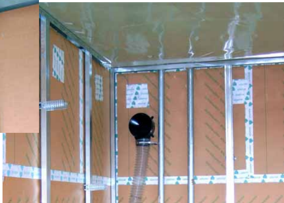
Sigillature per sistemi intelaiati in legno
