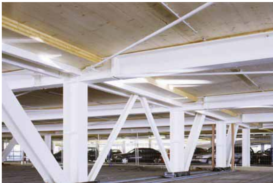
Resistenza strutturale al fuoco Sistema CLT
