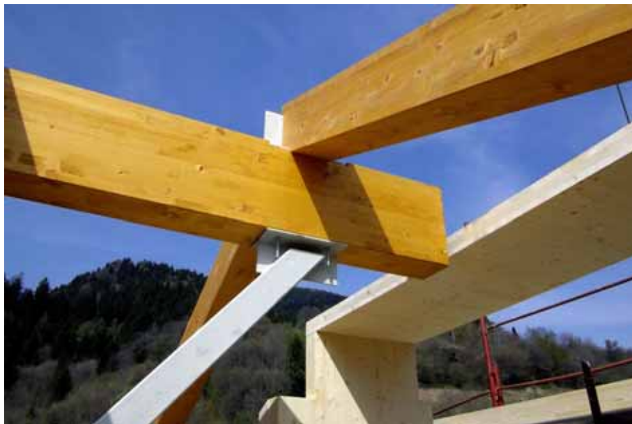
Sistema strutturale sbalzo di copertura
