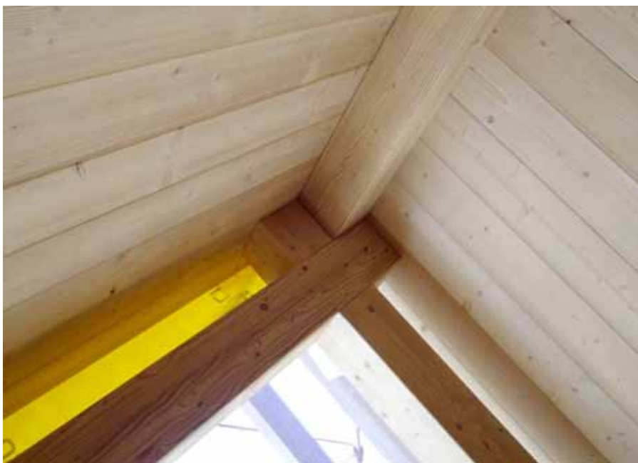
Sigillature per sistemi a pannelli tipo X-lam
