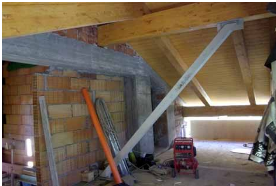
Sistema strutturale sbalzo di copertura
