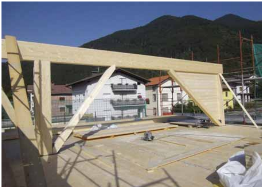
Telaio su primo solaio X-lam 200 mm
