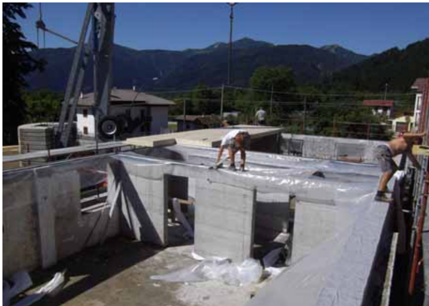
Cordolo di partenza con guarnizioni a tenuta
