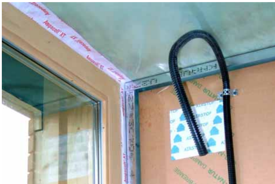
Sigillature per sistemi intelaiati in legno
