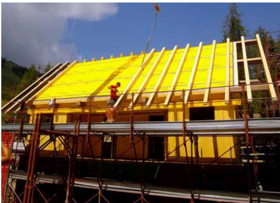
Sigillature per sistemi a pannelli tipo X-lam
